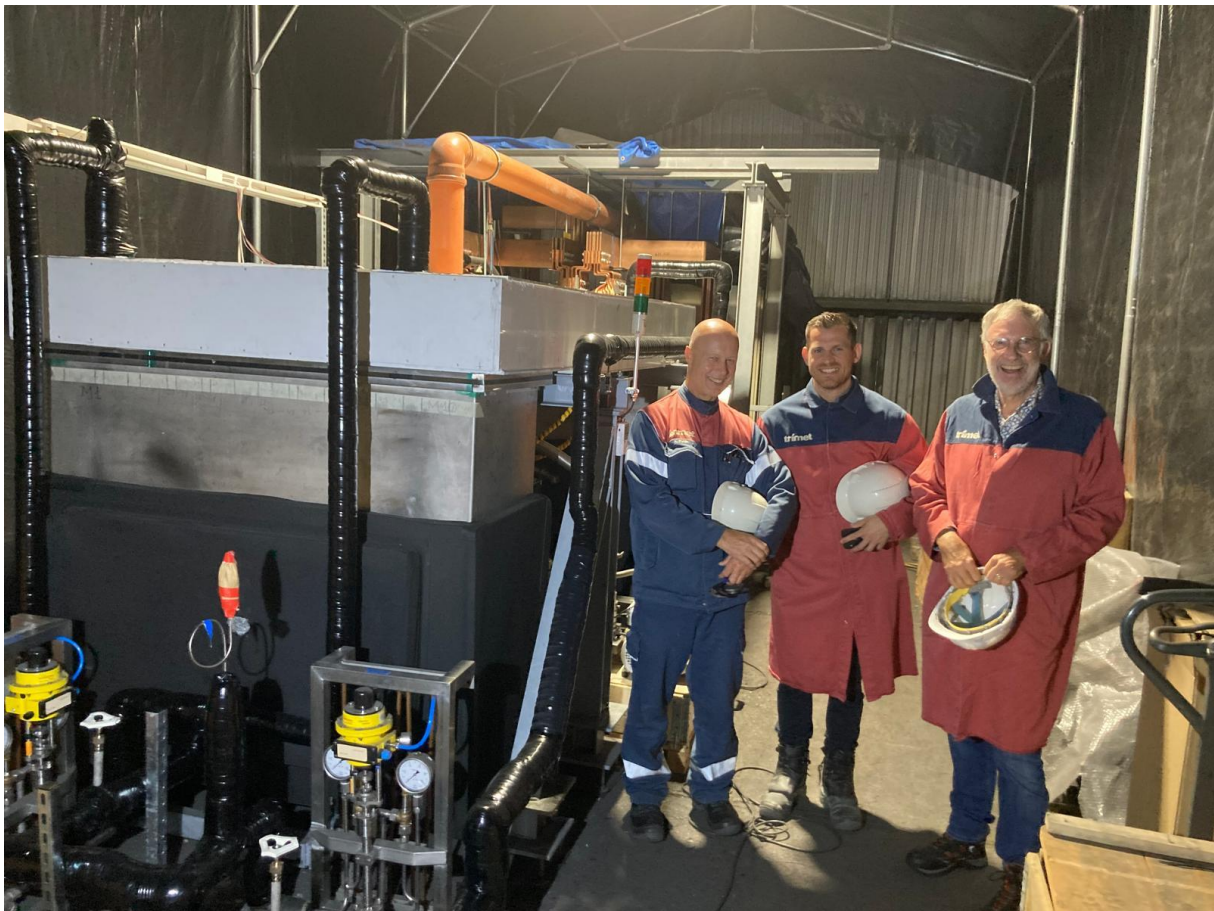
Bild 1 Von links nach rechts: Hr. Pytlik (Trimet), Hr. Ludwig (Trimet) und Dr. Reiser (VESC) neben dem aufgebauten Demonstrator.
